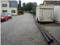
Die Schutzrohre für die Energie-, Wasser- und Telefonleitungen wurden lang ausgelegt bzw. von der Rolle vorbereitet.
