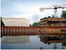
Nachdem das westliche Brückenlager fertiggestellt war, konnte nun ungehindert das am Ostufer des Brieskower Sees liegende Brückenlager eingeschalt und mit Eisengeflecht gefüllt werden.
