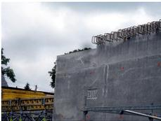
Mittlerweile ist auch das gegenüberliegende Brückenlager ausgeschalt und man erkennt nun schon das Brückenprofil.
