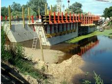
Das Hochwasser hatte am 09.07.2009 seine höchste Sommerwelle mit einem Pegelstand von 4,50 m an der Pegellatte in Brieskow erreicht und überflutete die Baugrube der Seebrücke um gut 10 cm über den Larssen.
